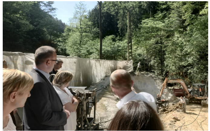
Bei der Besichtigung von einer der 27 Schadstellen.
